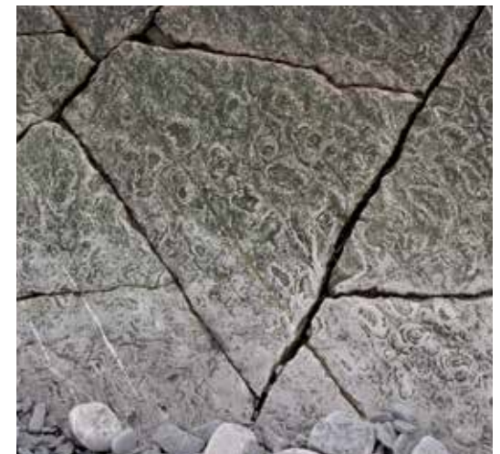
Detalle de una intersección entre varias fracturas más desordenadas, apreciables en el estrato anterior.
