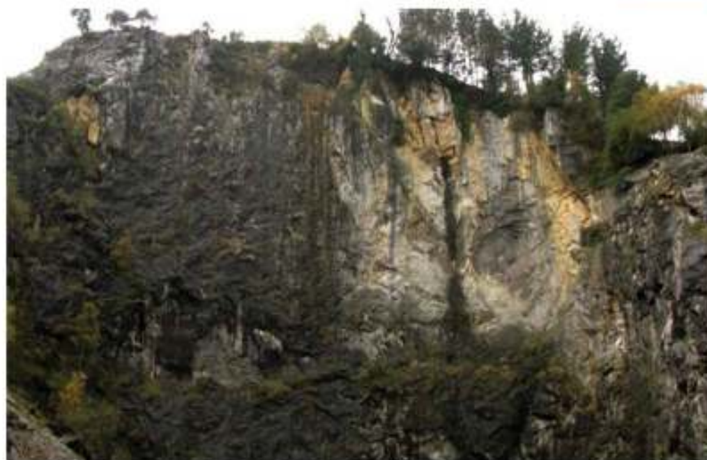
La superficie erosiva se encuentra en la parte superior de la cantera de Istiña.
