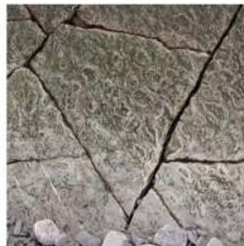
Detalle de una intersección entre varias fracturas más desordenadas apreciables en el estrato anterior
