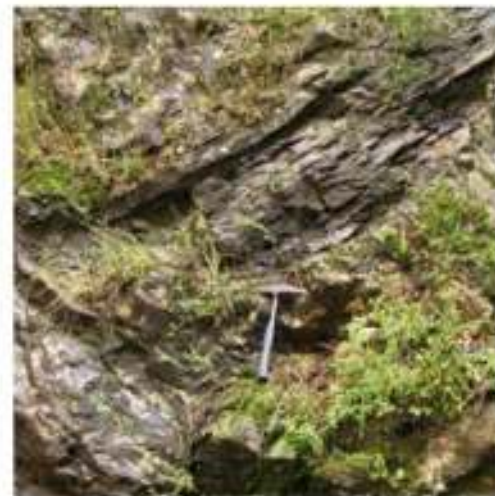
Detalle de un bloque lutítico plegado por el desplazamiento talud abajo.
