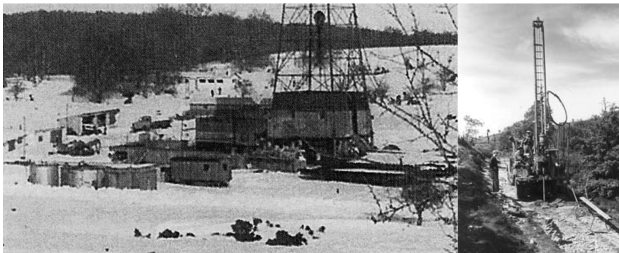
Figura 24. Izquierda: Sondeo de exploración Urbasa-1, perforado por CIEPSA en 1960 ( https://agurainberri.com/petroleo-en-agu-rain ). Derecha: Perforación de un pozo somero durante una adquisición sísmica en la Cuenca Vasco-Cantábrica.
