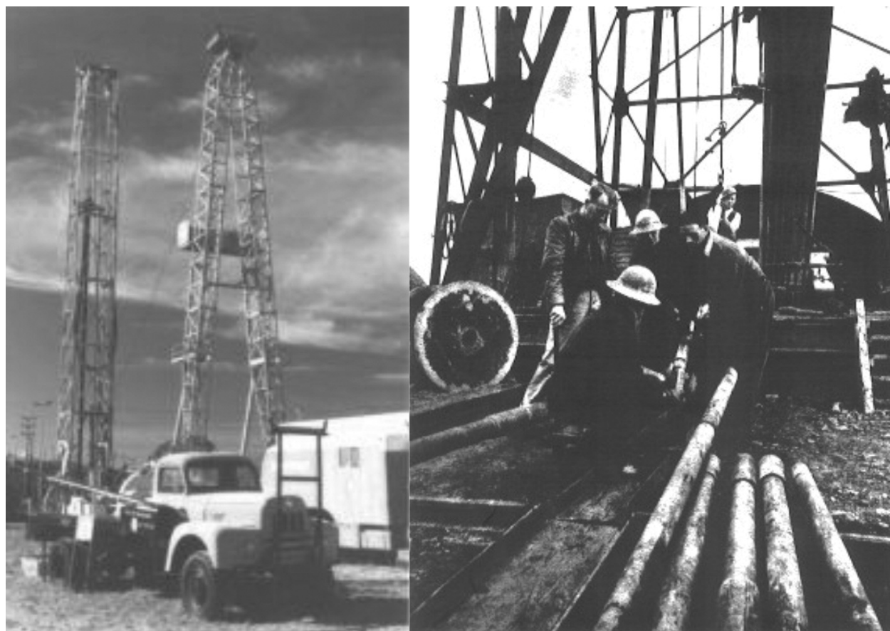
Figura 23. Izquierda: Perforación de un sondeo somero durante la campaña de adquisición sísmica 2D en Marcilla (Navarra). Derecha: Sondeo de exploración Marcilla-1 en 1953, operado por VALDEBRO ( www.marcillainfo.es/marcillacity.htm )
