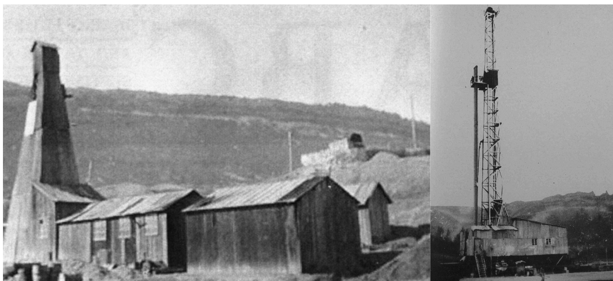
Figura 21. Torres perforando para CAMPSA en el núcleo del anticlinal de Zamanzas (Burgos). Izquierda: Torre Foraki perforando el sondeo Zamanzas-2 (S.3 según nomenclatura interna de CAMPSA). La foto fue tomada por personal de CIEPSA en noviembre de 1946 durante un fin de semana, aprovechando que el personal de CAMPSA estaba ausente. Derecha: Sonda Oil Well 64-B, adquirida por CAMPSA en el año 1947, perforando el sondeo Villanueva de Rampalay-1 (S.7) entre 1951 y 1953. Este fue el pozo más profundo perforado por CAMPSA en esta zona, el cual alcanzó los 2.177 m de profundidad.
