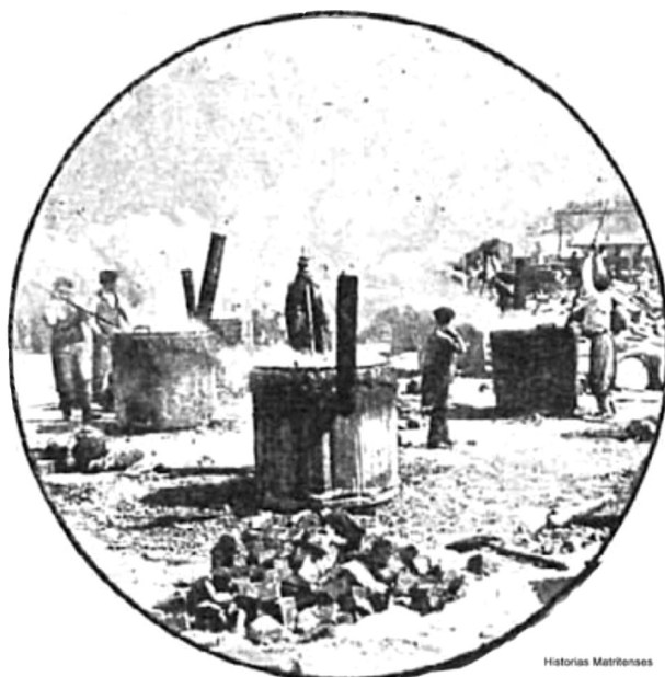
Figura 5. Hornillos utilizados en el asfaltado de las calles de Madrid (Revista Nuevo Mundo, 1902). Figure 5. Stoves used during the asphalting of Madrid streets (Revista Nuevo Mundo, 1902).
