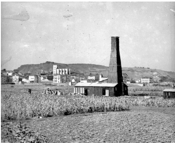
Figura 3. Izquierda: Torre de perforación propiedad de la “Sociedad Española de Sondeos Foraki” en el sondeo de Zumaya (Guipúzcoa), junto al Río Urola (ca. 1939-40). Al fondo se observa la iglesia de San Pedro (Zumaya). Derecha: Cabeza del pozo Zumaya (1940) quemando gas producido durante la perforación (Marchesi, 1942).
